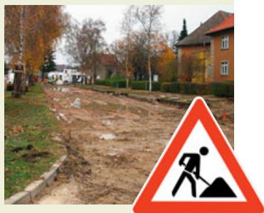
Baustelle vor der Tür. Nach der Seestraße wird jetzt die Berliner Straße saniert.
